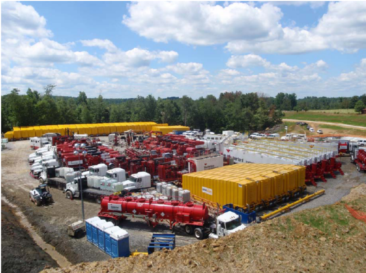
Bild 3: Frac -Vorbereitung einer Bohrung des Marcellus-Gasfeldes im Bundesstaat West Virginia. Lastwagen mit Frischwasser und Tanks zur Aufnahme des Abwassers einer Bohrstelle. (Quelle: SGEIS – Report, 30. September 2009 [7])
